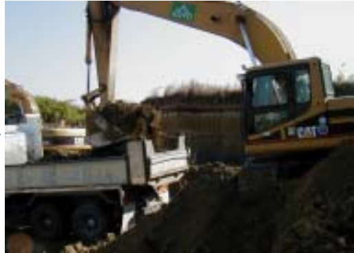
攪拌後の用土積み込み状況
