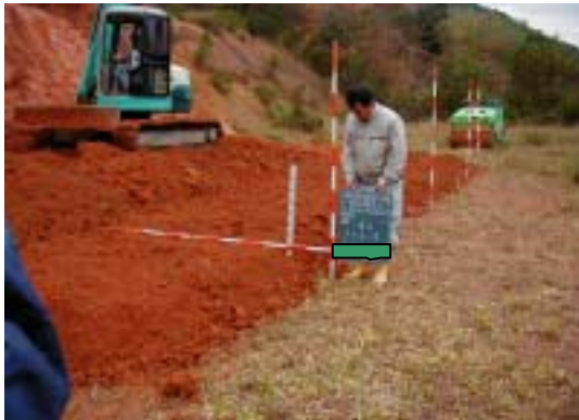
試験盛土(巻き出し状況)
