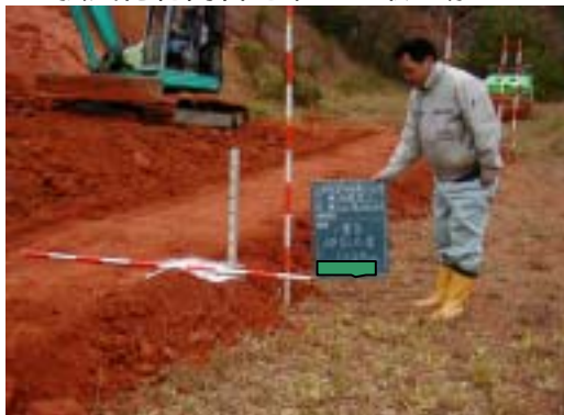
試験盛土(締め固め状況)
