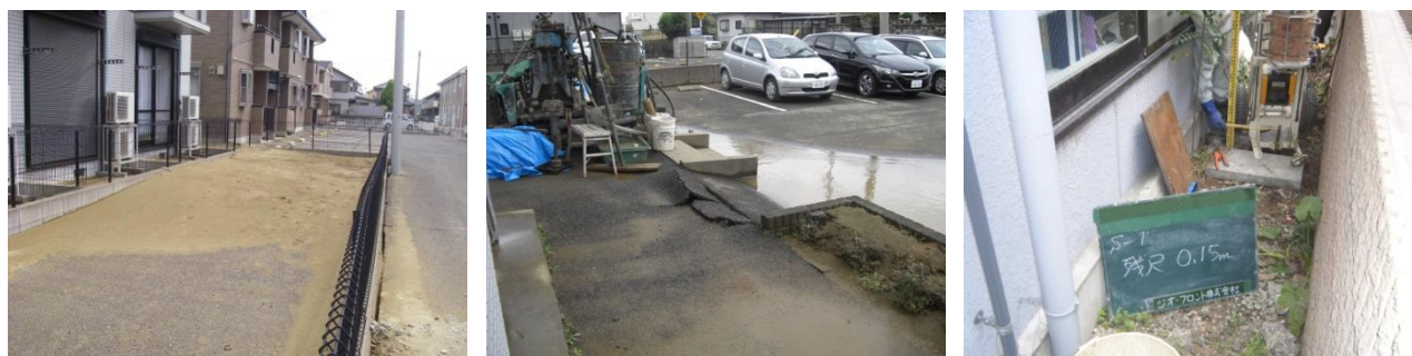
1)噴砂・堆積厚さ30cm(神栖市) 2)側方流動による隆起(神栖市) 3)試験状況(浦安市1地区)
